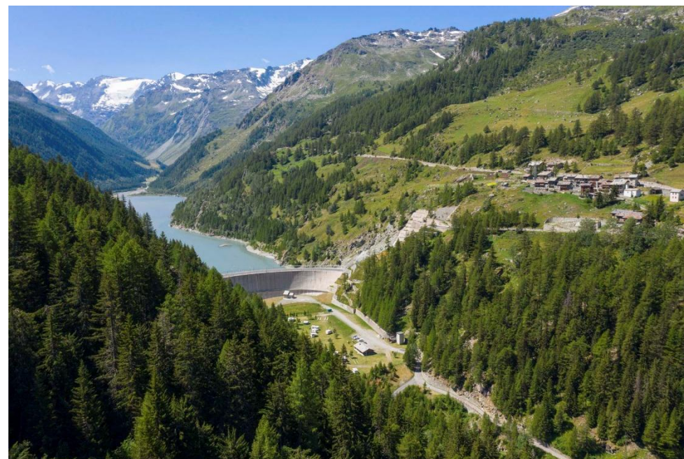
© Regione Autonoma Valle d'Aosta - Barrage de Beauregard.
